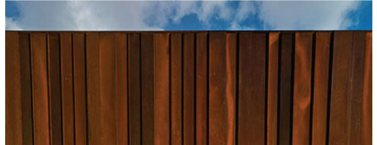
Herstellung der vier Elemente aus Corten-Walzstahl, der innerhalb von ein paar Wochen seinen Rostprozess vollendet hat, ist unempfindlich gegen Witterungseinflüssen und hat eine charakteristische Patina. Die verschiedenen Schriftzüge werden ausgelasert und bringen Leichtigkeit in die starren Elemente.
