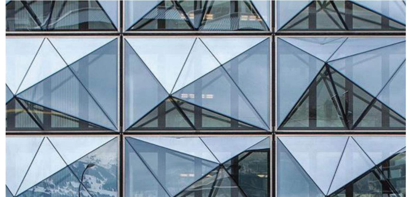
kurze, gekantete Elemente aus Edelstahl, entweder poliert oder gebürstet deuten die ‚Mühlradelemente‘ an und schaffen so mehr Transparenz.
