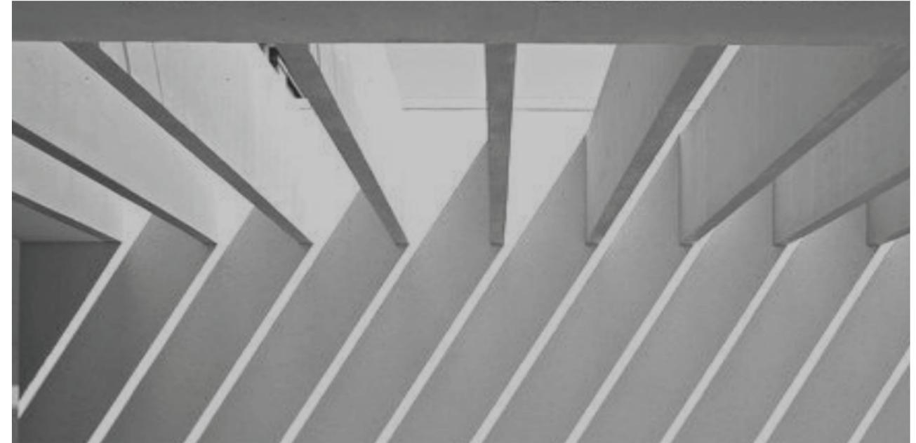
Die Betonfertigteile werden mit Farbpigmenten versehen um einen sehr hellen, weißen Beton zu bekommen. Die Oberflächenbearbeitung der Betonteile könnte glatter Beton sein oder eine in Holzoptik ausgeführte, sägerauhe Bretterschalung sein.
