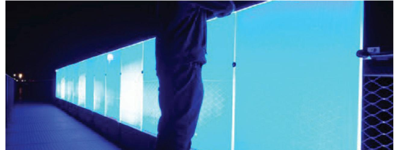
Die VSG Glas-/ oder Acrylglasplatten in verschiedenen Farben werden nachts durch LED flächig beleuchtet und erscheinen so als farbiges Lichtobjekt.
