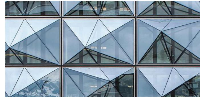
kurze, gekantete Elemente aus Edelstahl, entweder poliert oder gebürstet deuten die 'Mühlradelemente' an und schaffen so mehr Transparenz. Die Stirnseiten können farbig lackiert werden.
