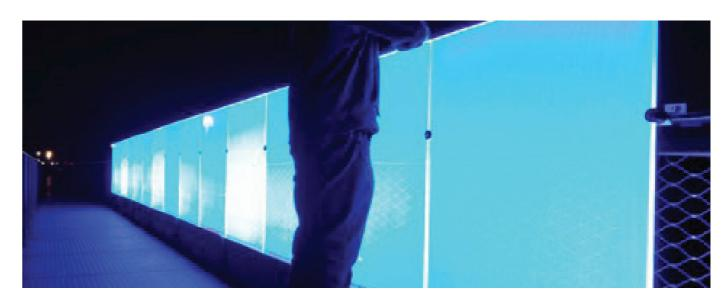
Die VSG Glas-/ oder Acrylglasscheiben in verschiedenen Farben werden nachts durch LED flächig beleuchtet und erscheinen so als farbiges Lichtobjekt.
