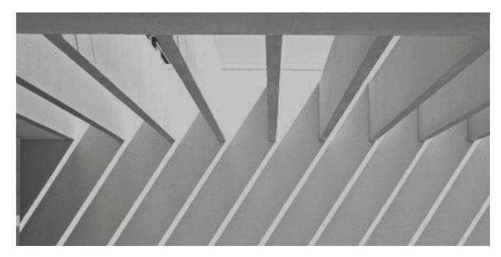
Die Betonfertigteile werden mit Farbpigmenten versehen um einen sehr hellen, weißen Beton zu bekommen. Die Oberflächenbearbeitung der Betonteile könnte glatter Beton sein oder eine in Holzoptik ausgeführte, sägerauhe Bretterschalung sein.
