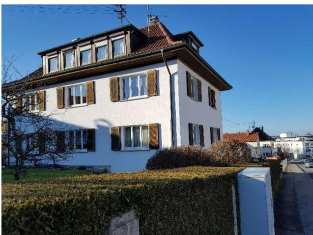
**Foto 11:** Nordost- bzw. Südostfassade, viele Klapppläden, Rollladenkästen an den Gaubenfenstern
