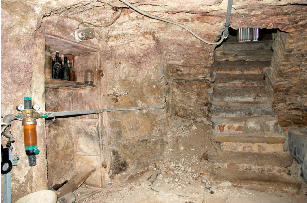
Abb. 36 Schwanenstraße 5, Gewölbekeller. Blick in die Südostecke mit dem Übergang vom nordöstlichen Gewölbekeller (links, mit raumhoher Wandnische) zur Südwand des westlichen Gewölbekellers mit dem Treppenabgang vom Erdgeschoß (rechts).
