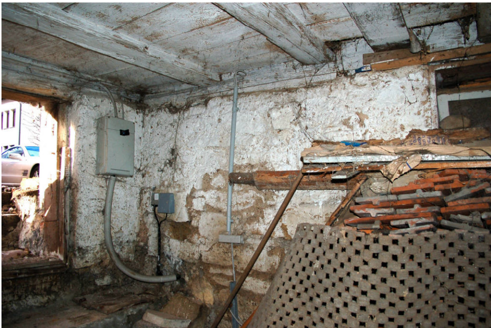
Abb. 49 Schwanenstraße 9, Keller. Blick durch den Kellerraum nach Nordwesten. Links die Westwand mit der Eingangstür, rechts die Nordwand mit dem nachträglich eingebrochenen Fensterchen.
