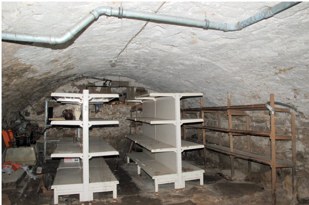
Abb. 14 Friedrichstraße 74, westlicher Keller. Blick durch den Kellerraum nach Norden.
