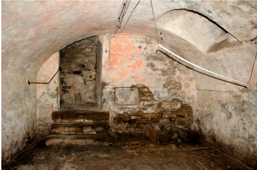
Abb. 20 Friedrichstraße 76, Gewölbekeller. Blick durch den Keller auf die östliche Stirnseite. Links Zugangsöffnung, in der Wandmitte rechteckige, flachgedeckte Wandnische.
