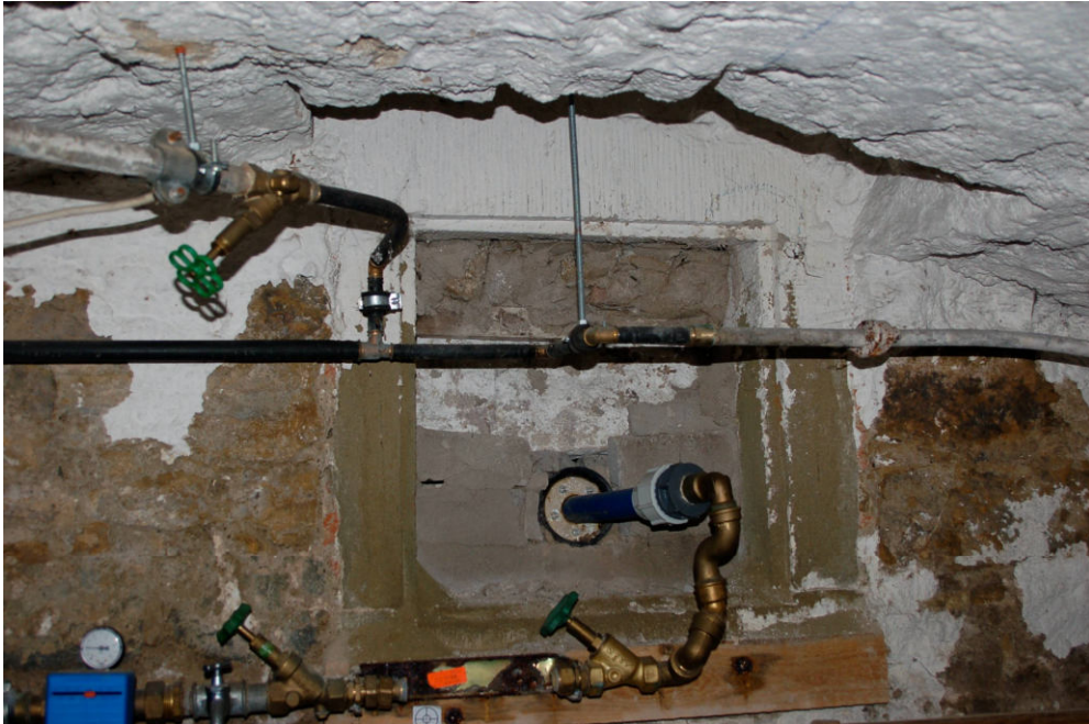
Abb. 15 Friedrichstraße 74, westlicher Keller. Vermauerte Fensteröffnung mit Sandsteinfenstergewände an der nördlichen Stirnwand.
