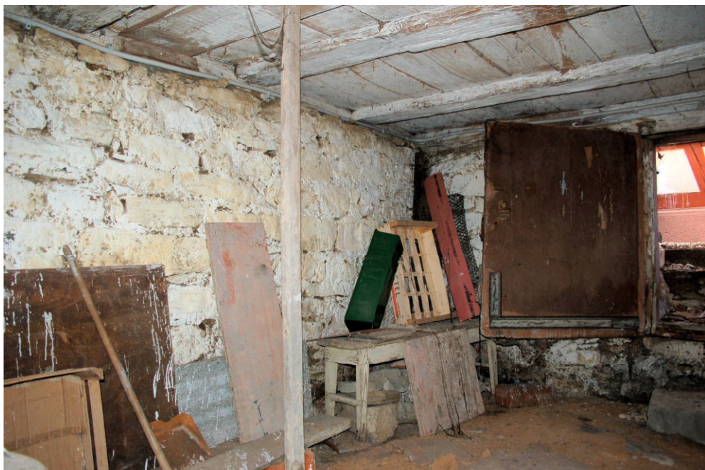
Abb. 47 Schwanenstraße 9, Keller. Blick durch den Kellerraum nach Südwesten mit der öffnungslosen Südwand (links), die Westwand mit der Eingangsöffnung rechts.
