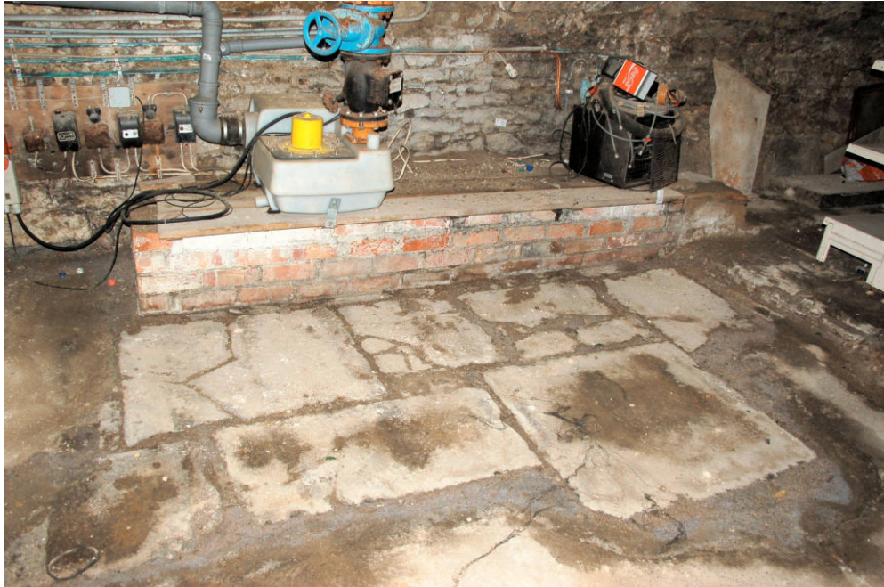
Abb. 19 Friedrichstraße 74, westlicher Keller. Natursteinplattenboden im südlichen Kellerbereich.
