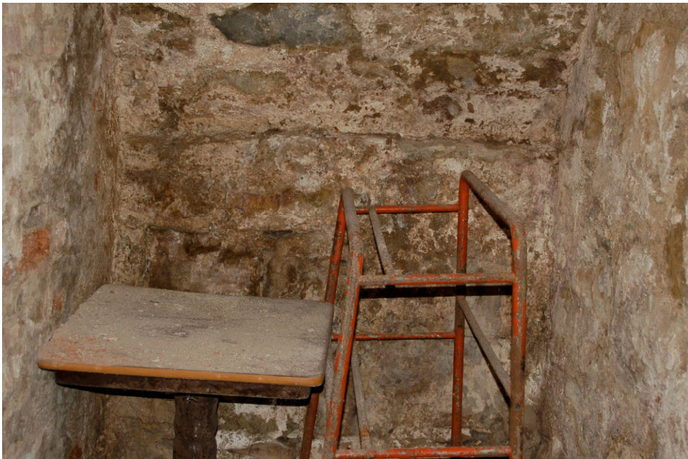
Abb. 8 Friedrichstraße 74, östlicher Keller. Südliches Ende der östlichen Längswand mit großformatigem Bruchsteinmauer und schmalen Absatz zum Ansatz des Gewölbes.
