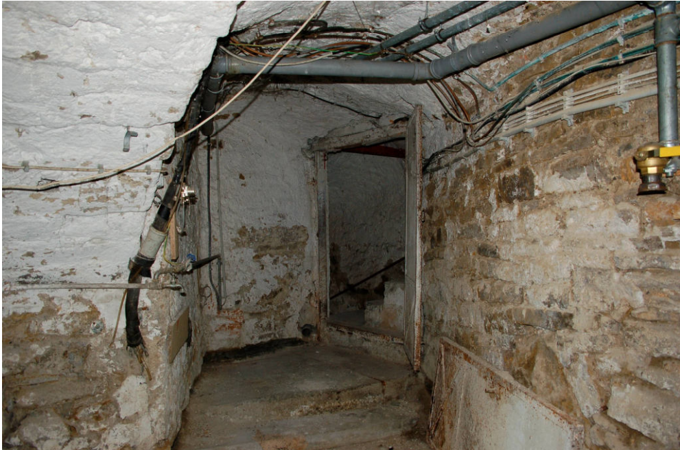
Abb. 12 Friedrichstraße 74, westlicher Keller. Blick aus dem Hauptkeller nach Südosten in den schrägen Durchgang zum südseitigen Treppenaufgang.
