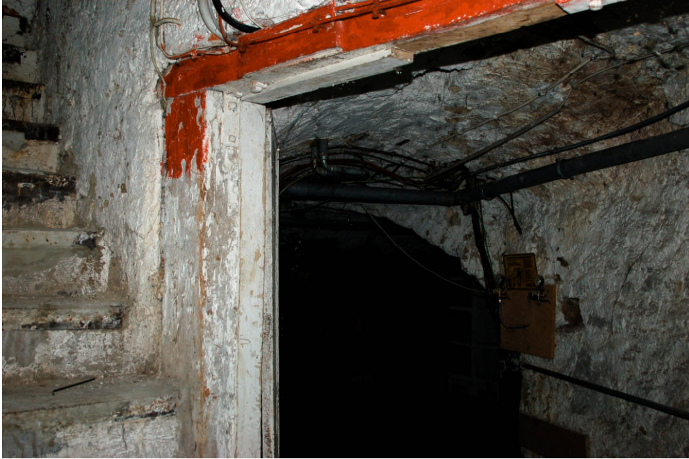
Abb. 9 Friedrichstraße 74, südseitiger Treppenaufgang. Blick vom Treppenpodest auf den Zugang zum westlichen Keller mit eichenem Blockrahmen.
