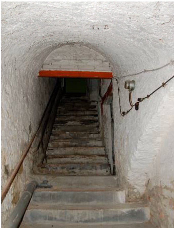
Abb. 6 Friedrichstraße 74, östlicher Keller. Blick durch den südseitigen Treppenabgang nach Westen empor zum Erdgeschoß
