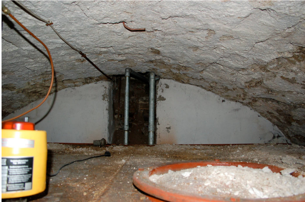
Abb. 3 Friedrichstraße 74, östlicher Keller. Blick unter dem Gewölbescheitel nach Norden auf die ansonsten unzugängliche nördliche Stirnwand des Kellers.
