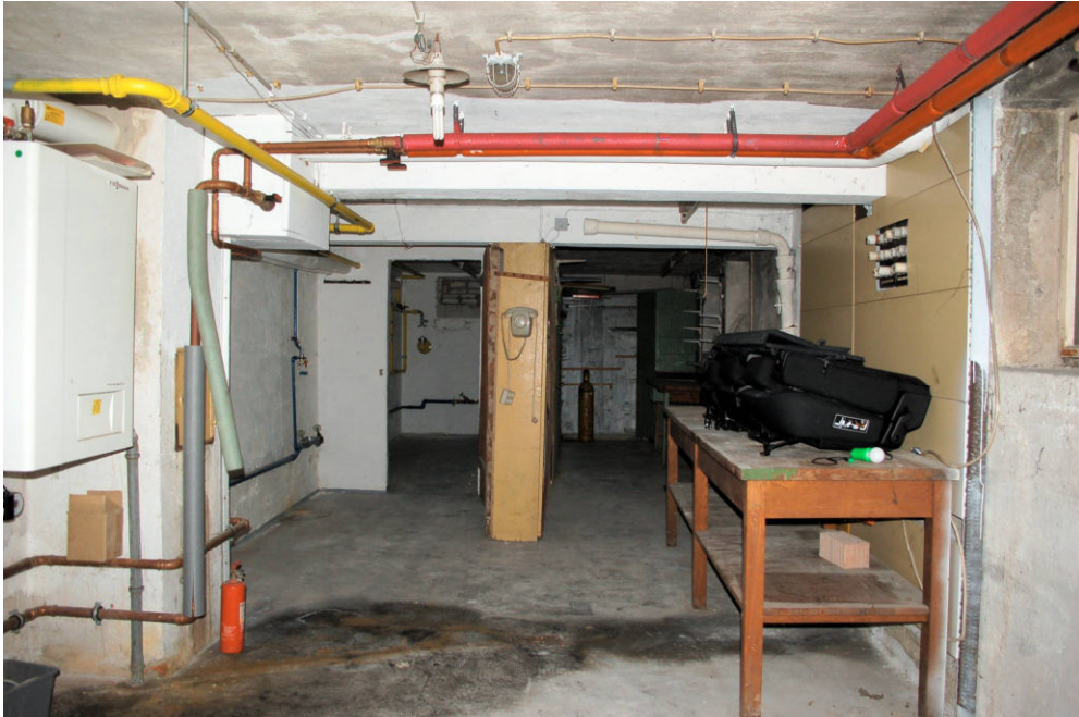
Abb. 29 Friedrichstraße 29, südlicher, moderner Keller. Blick durch den modern betonierten Kellerraum nach Osten.
