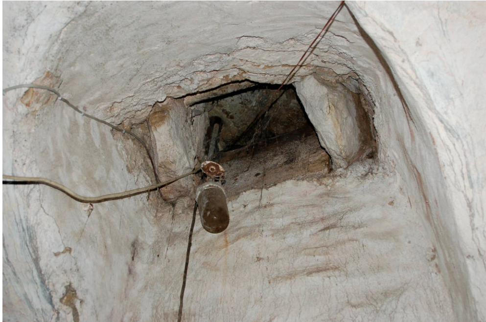
Abb. 23 Friedrichstraße 76, Gewölbekeller. Blick nach oben in den großen Luftschacht vor der nördlichen Längsseite.
