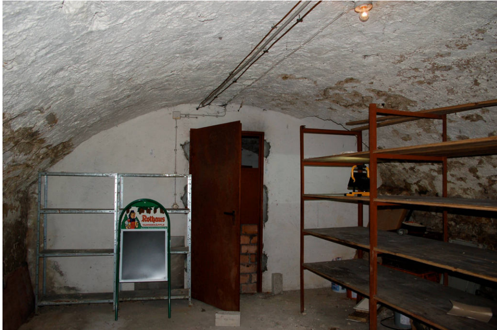
Abb. 1 Friedrichstraße 74, östlicher Keller. Blick durch den Hauptraum nach Norden auf die moderne Trennwand zum nördlichen Kellerteil.
