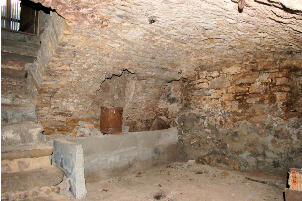
Abb. 37 Schwanenstraße 5, Gewölbekeller. Blick nach Südwesten in den westlichen Keller. Links der Treppenabgang vom Erdgeschoß, rechts die westliche Stirnwand. Mittig der westliche Abschnitt der Südwand mit zwei vermauerten, nachträglich eingebrochenen Luftschächten.
