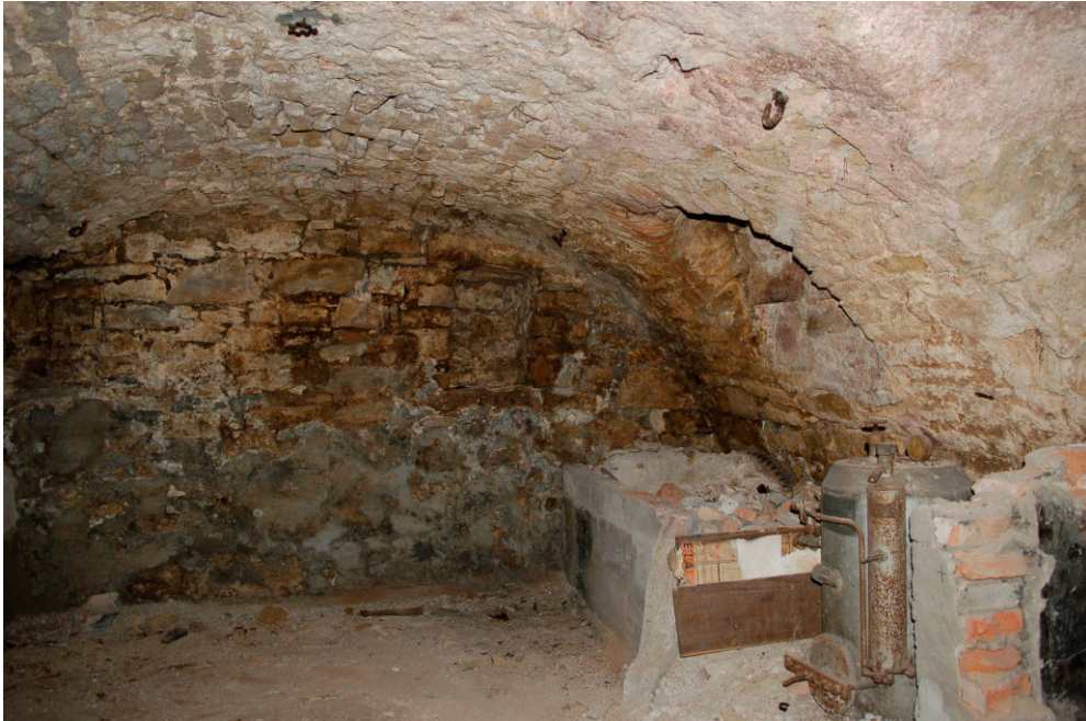
Abb. 34 Schwanenstraße 5, Gewölbekeller. Blick nach Nordwesten in den westlichen Kel- lerraum.
