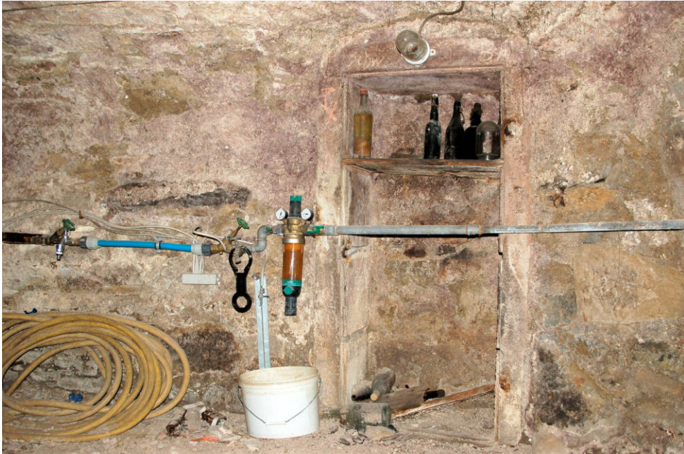
Abb. 32 Schwanenstraße 5, Gewölbekeller. Blick auf den südlichen Abschnitt der Ostwand des nordöstlichen Kellers mit raumhoher, sandsteinverkleideter Wandnische.
