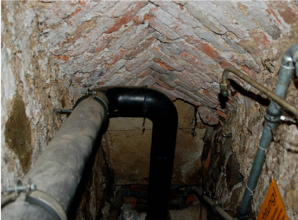
Abb. 17 Friedrichstraße 74, westlicher Keller. Blick in den Luftschacht an der Westseite mit firschrätzförmig gesetzter Backsteinüberdachung.
