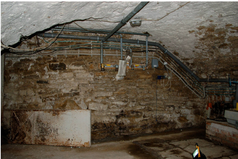
Abb. 18 Friedrichstraße 74, westlicher Keller. Blick auf die südwestliche Stirnwand, die im linken Drittel ohne Bruch rundlich in den schrägen Kellerzugang übergeht.
