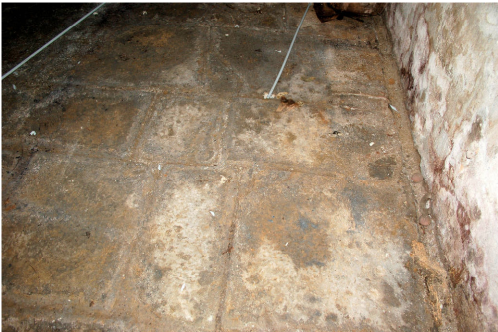
Abb. 28 Friedrichstraße 76, Gewölbekeller. natursteinplattenboden im nördlichen Kellerbereich.
