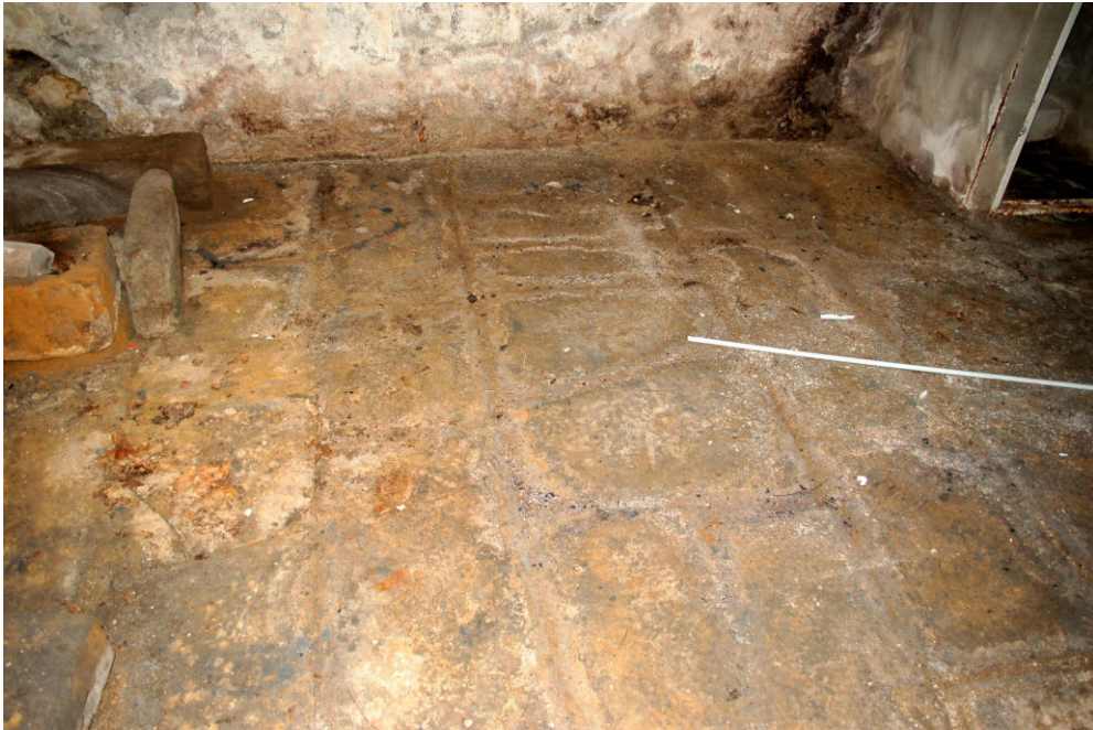
Abb. 27 Friedrichstraße 76, Gewölbekeller. Natursteinplattenboden im südöstlichen Kellerbereich.
