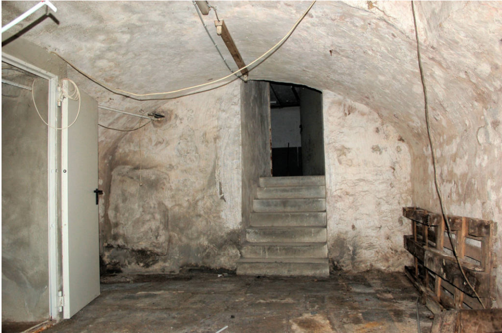
Abb. 22 Friedrichstraße 76, Gewölbekeller. Blick durch den Kellerraum nach Westen auf die westliche Stirnwand mit jüngerem Durchbruch zum modernen Nachbarkeller. Links in der Mitte der Südwand ebenfalls moderne Zugangsanlage vom benachbarten modernen Keller.
