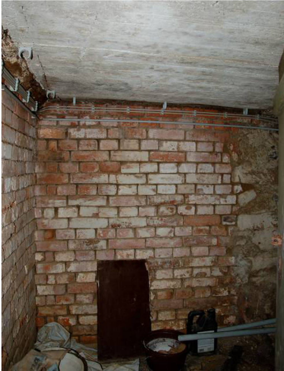
Abb. 45 Schwanenstraße 7, Keller. Blick auf die nördliche Stirnwand des Treppenabganges mit modernen Vollziegelmauerwerk und Betondecke. Links oben eingemauert ein historischer Deckenbalken.
