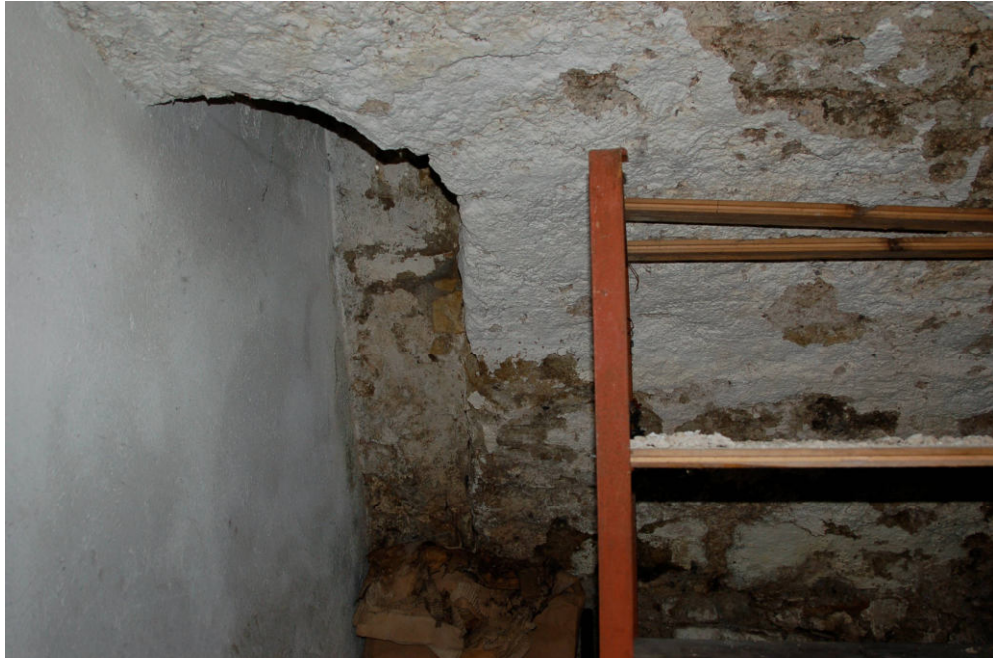
Abb. 2 Friedrichstraße 74, östlicher Keller. Nördlicher Luftschacht an der östlichen Längsseite, der von der modernen Trennwand zum nördlichen Kellerteil überschritten wird, aber schon zuvor in Bruchsteinmauerwerk vermauert wurde.
