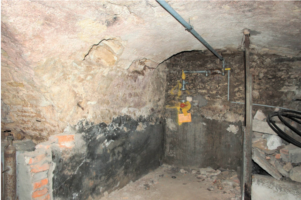
Abb. 35 Schwanenstraße 5, Gewölbekeller. Blick nach Nordwesten in den nordöstlichen Gewölbekeller, links der Übergang zur Nordseite des westlichen Gewölbekellers.
