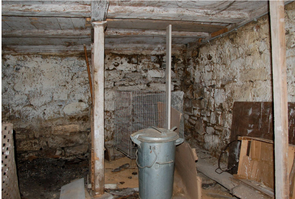
Abb. 46 Schwanenstraße 9, Keller. Blick durch den Kellerraum nach Südosten mit der öffnungslosen Südwand (rechts) und der öffnungslosen Ostwand (links).
