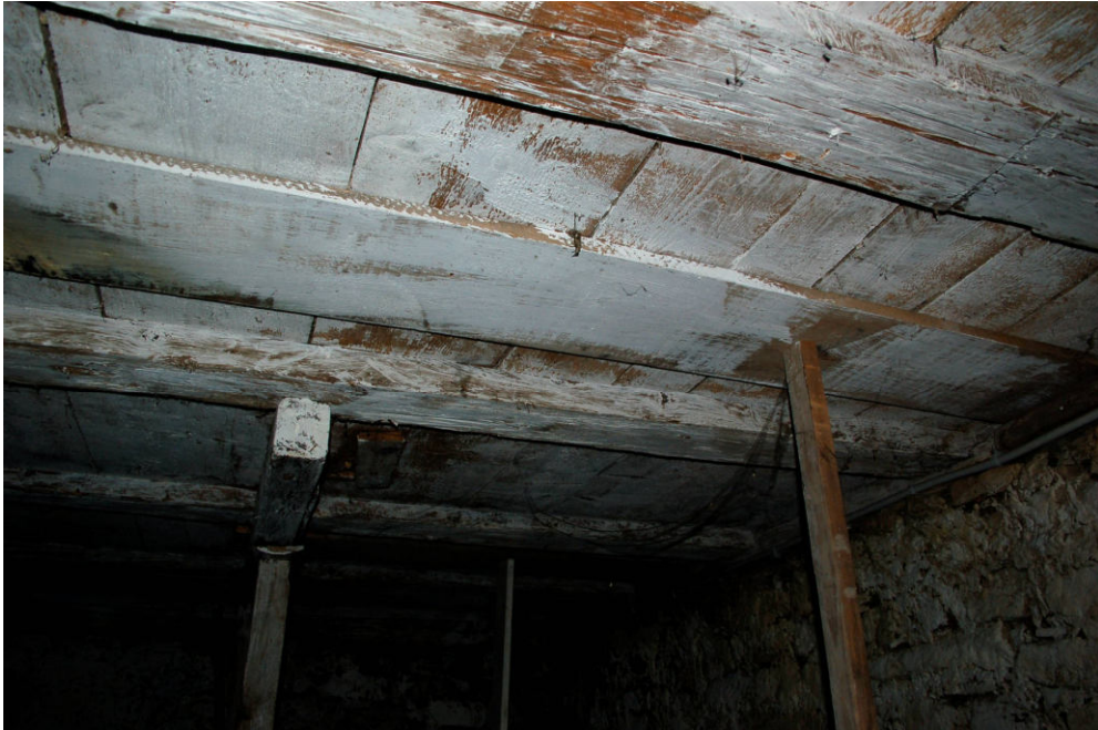
Abb. 50 Schwanenstraße 9, Keller. Nadelholzdeckengebälk mit eingenu tetem Fehlboden aus breiten Nadelholzbrettern im mittleren Deckenbereich.
