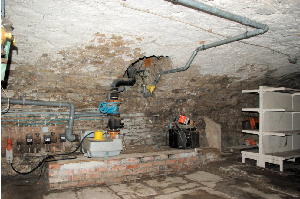
Abb. 16 Friedrichstraße 74, westlicher Keller. Blick durch den Kellerraum nach Nordwesten auf die Westwand mit modern erneuerter Bank und darüberliegendem, steil ansteigendem Luftschacht.
