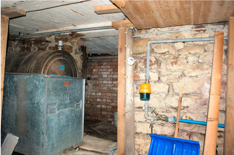
Abb. 41 Schwanenstraße 7, Keller. Blick nach Südwesten gegen die Westwand mit dem mittigen Durchgang zum Treppenabgang aus dem Erdgeschoß.
