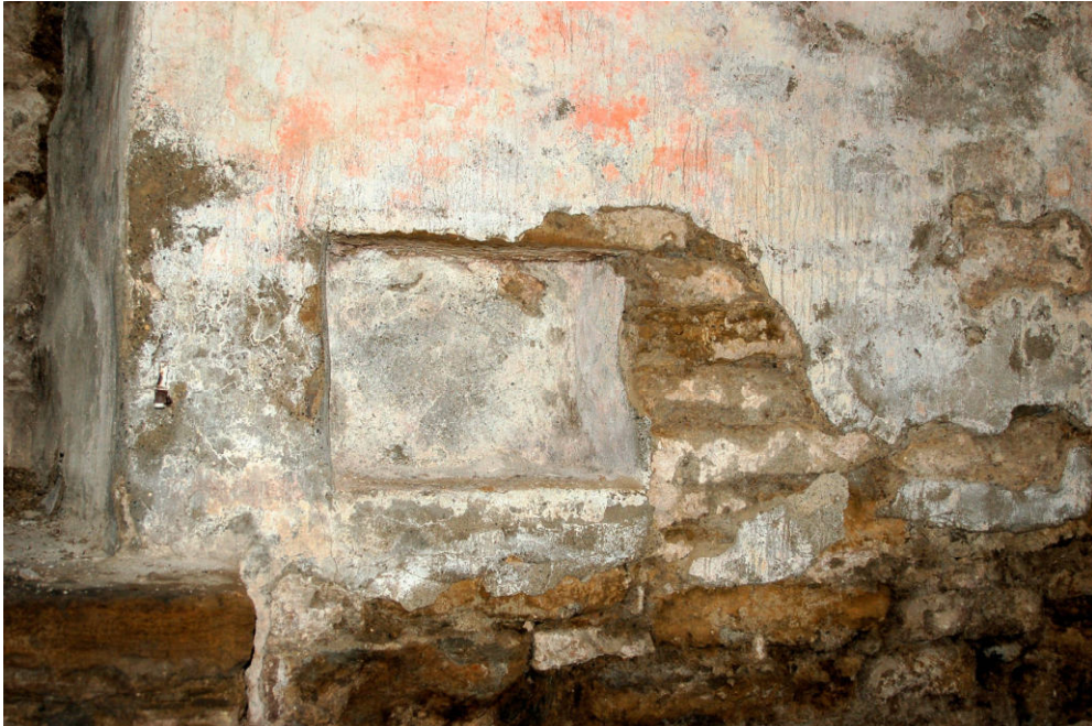
Abb. 21 Friedrichstraße 76, Gewölbekeller. Flachgedeckte Wandnische in der Mitte der östlichen Stirnwand.
