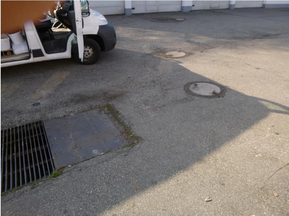
Abbildung 12: Waschplatz mit Schlammfang und Ölabscheider; Schadensbereich 4
