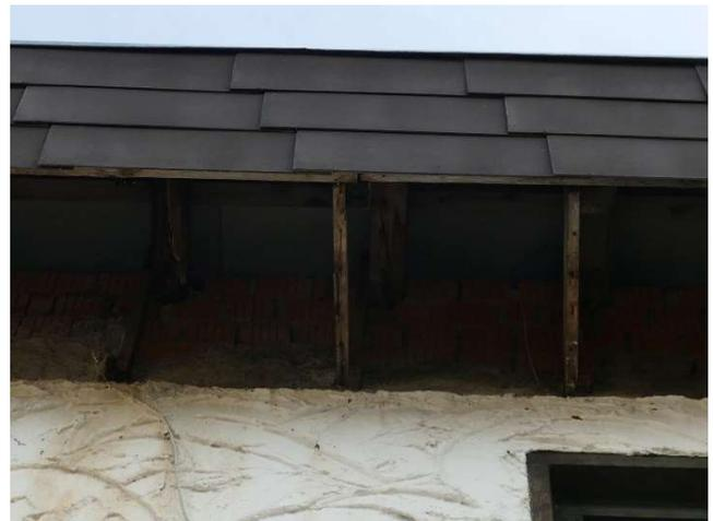
**Foto 17 :** Schadhafte Stellen am Dachvorsprung
