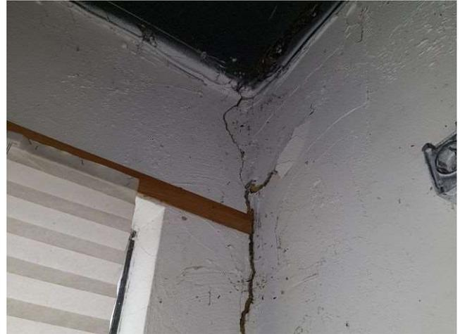
Foto 7, 8: Ein-/ Ausflugsstelle 1 an einem Riss am Mauerwerk von außen und innen
